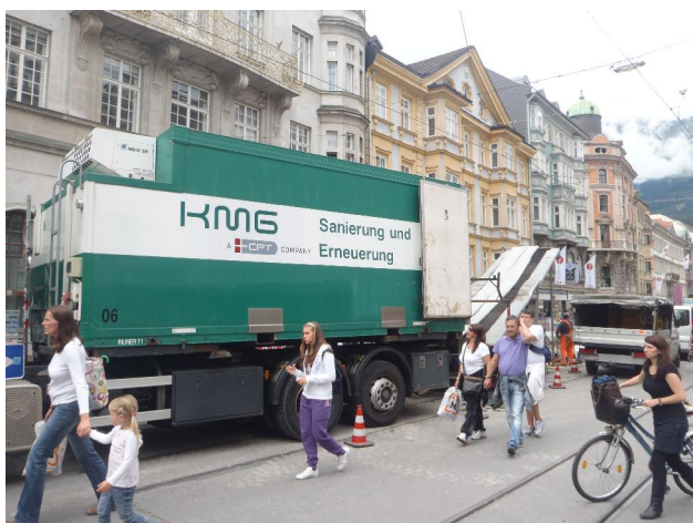
Baustellensituation während der Sanierung
