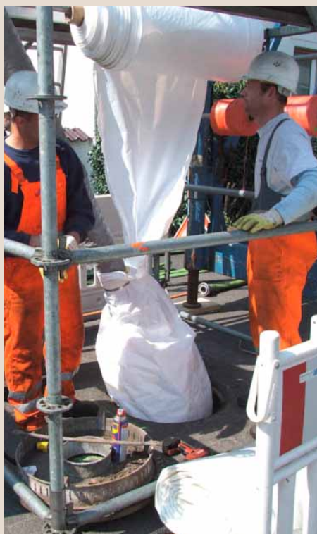
Abbildung 3: Einbau des Preliners und der Hilfsseile
