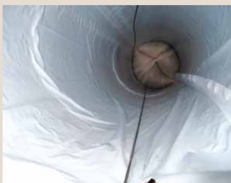
Abbildung 4: links: Positionierung der Messkabel im Scheitel und in der Sohle zwischen Preliner und Nadel filzliner; rechts: Fixierung der Messkabel im Messschacht 2590
